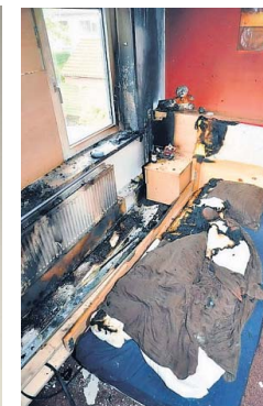
Een slaapkamer na een brand. Roken in bed is nog altijd de belangrijkste oorzaak van branden met dodelijke afloop. FOTO BRANDWEER DRENTH
