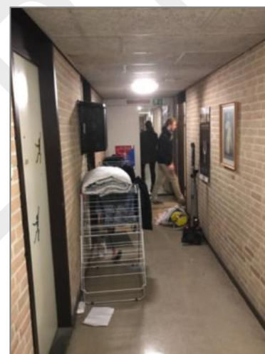
Punt 6: Vluchtwegen en branddeuren blokkeren
