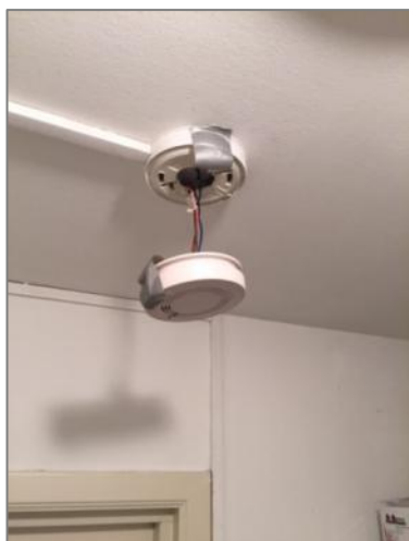
Punt 1: Demonteren van de brandveiligheidsvoorzieningen
